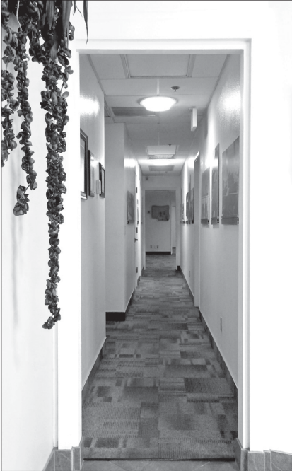
Un pasillo en GreenZone iluminado por tubos solares.
